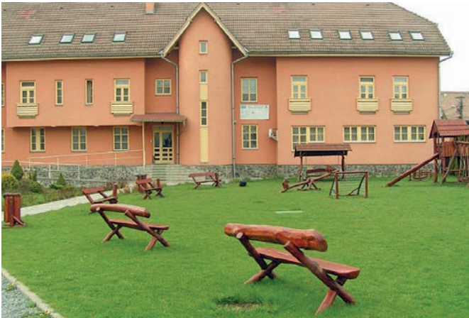
In dreijähriger Bauzeit wurde ein Spital errichtet.
