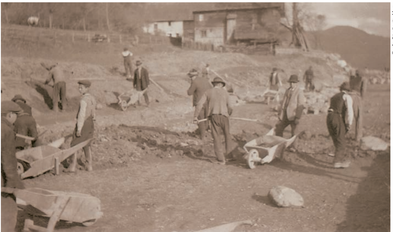
Arbeitskräfte bei den Straßenbauarbeiten bei Triebendorf. Zu sehen ist, wie Teile des Hügels abgetragen und mit Karren wegbefördert werden musste. Ob es sich bei den abgebildeten Personen um die Roma-Zwangsarbeiter handelt, konnte nicht eindeutig geklärt werden.
